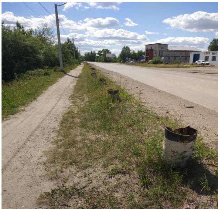
Фото 16 – г. Красновишерск, ш. Соликамское, до р. Вижайха. Демонтаж стоек разрушенного ограждения и строительство на его месте ДО У-3 справа
