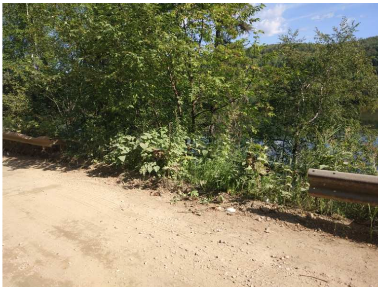
Фото 18 – а/д «Красновишерск – Вая» - Вишерогорск, км 5+800. Ремонт ДО
