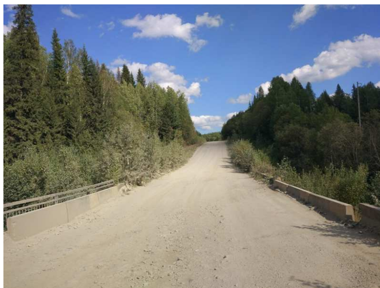
Фото 21 – а/д «Красновишерск – Вая», км 71+300. Ремонт ДО
