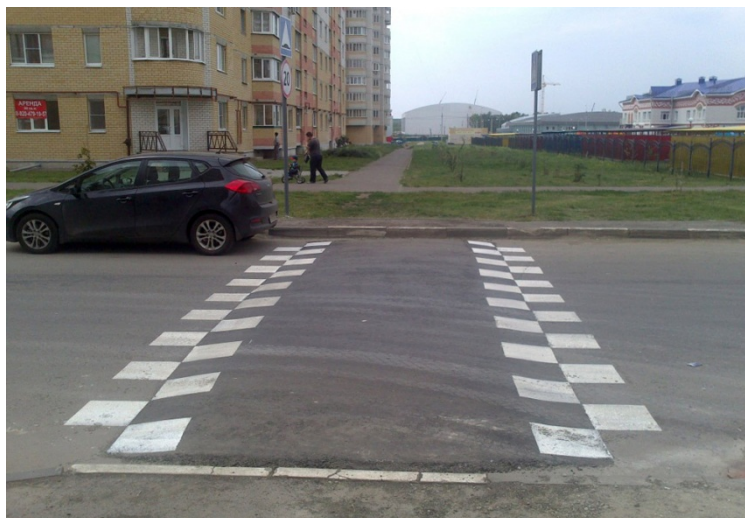
Фото 12 – Устройство искусственной дорожной неровности. Пример №1
