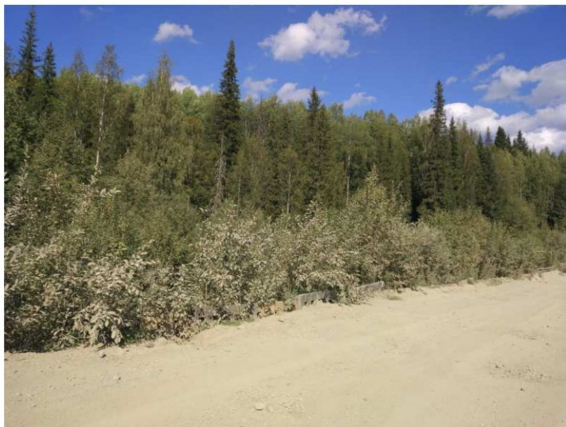
Фото 22– а/д «Красновишерск – Вая», км 71+250. Ремонт ДО
