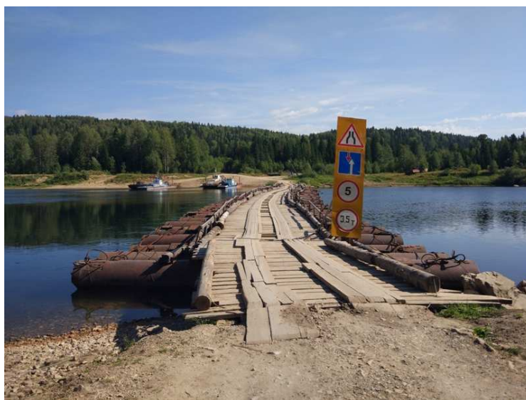
Фото 4 – а/д «Красновишерск – Вая» - Вишерогорск, км 6+250. Строительство моста через р. Вишера
