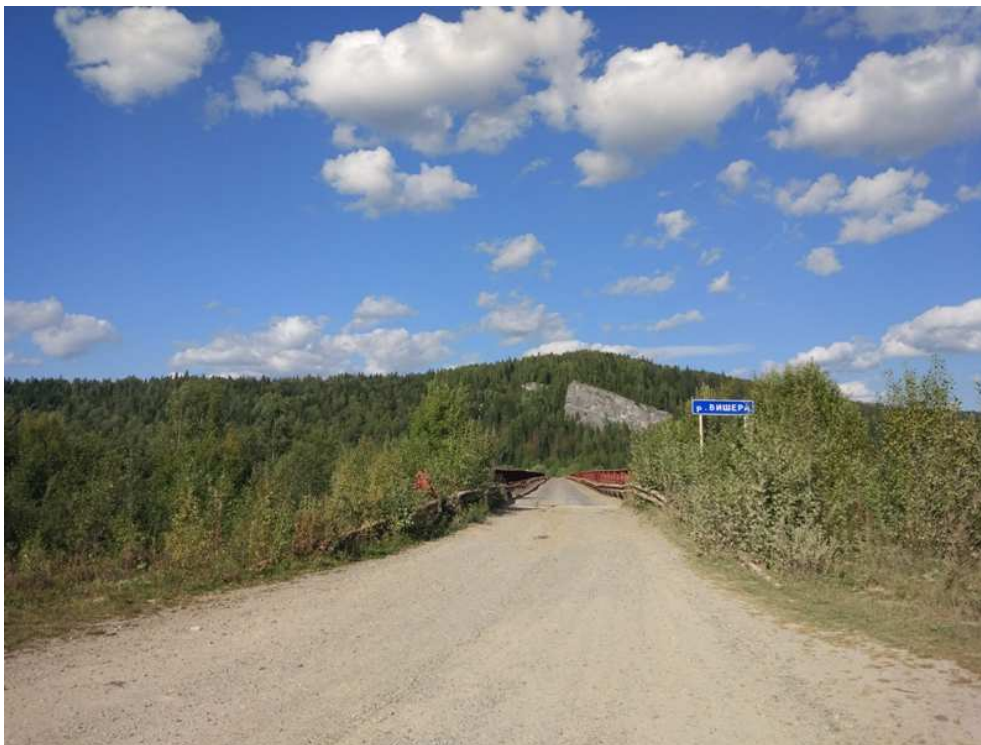
Фото 6 – а/д «Красновишерск – Вая», км 99+800. На мосту через р. Вишера требуется установка знаков встречного разъезда 2.6(2.7)
