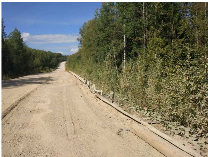
Фото 27 – а/д «Красновишерск – Вая», км 20+000. Ремонт ДО
