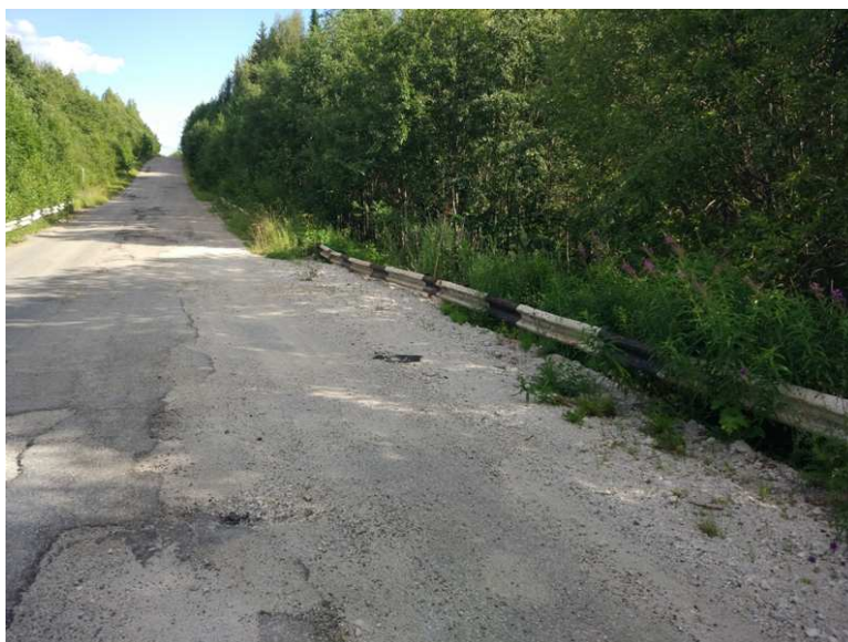
Фото 17 – а/д «Красновишерск – Антипина», км 38+800. Ремонт ДО
