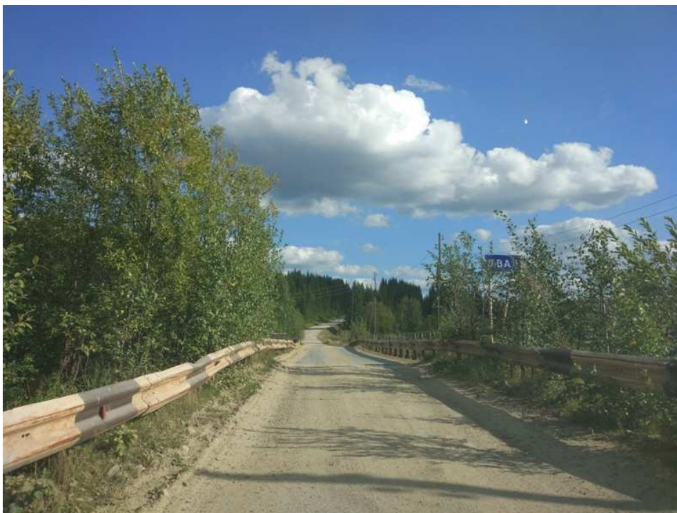
Фото 7 – а/д «Красновишерск – Вая», км 101+700. На мосту через р. Вая требуется установка знаков встречного разъезда 2.6(2.7)
