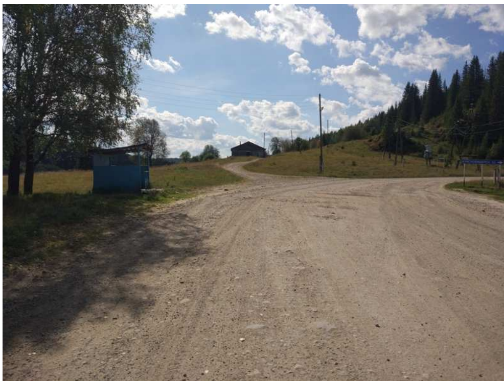
Фото 5 – а/д «Красновишерск – Вая», 62 км. Рекомендуется перенос автобусной остановки.
