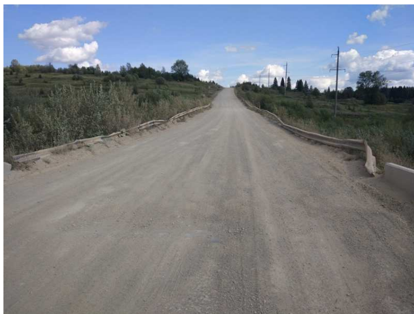
Фото 23 – а/д «Красновишерск – Вая», км 40+710. Ремонт ДО
