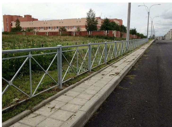
Фото 11 – Пример пешеходного ограждения
