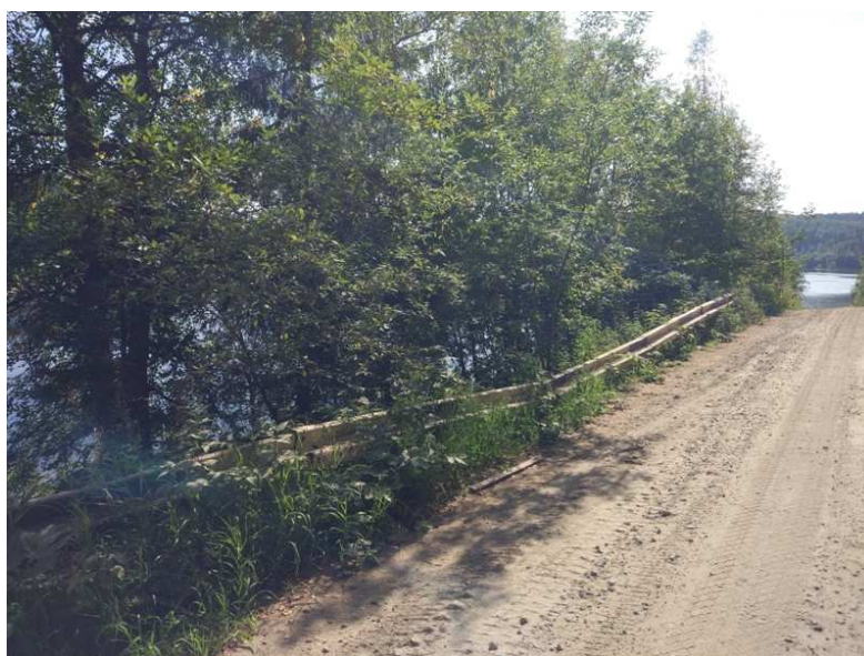
Фото 19 – а/д «Красновишерск – Вая» - Вишерогорск, км 5+800. Ремонт ДО
