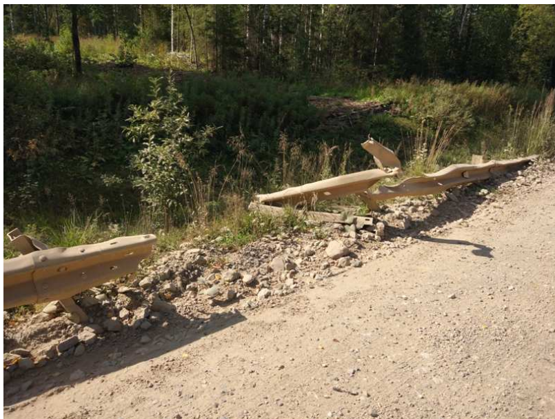
Фото 24 – а/д «Красновишерск – Вая», км 29+800. Ремонт ДО
