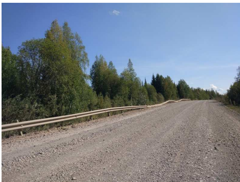
Фото 25 – а/д «Красновишерск – Вая», км 28+550. Ремонт ДО
