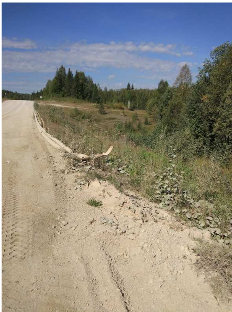
Фото 28 – а/д «Красновишерск – Вая», км 15+500. Ремонт ДО
