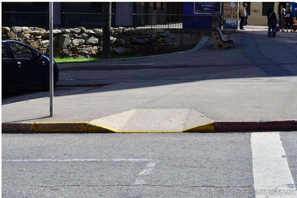
Фото 8 - Устройство пандуса. Пример №1
