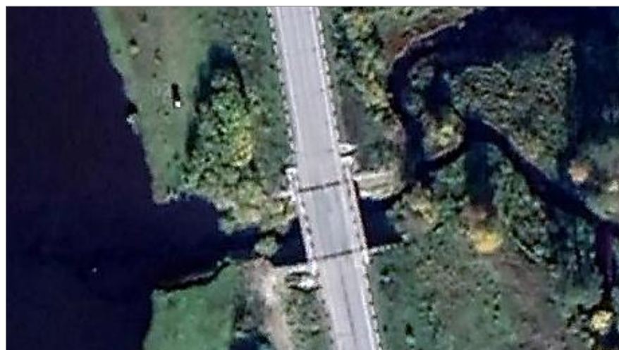
Рисунок 1.5.3 - «Фотоснимок моста через р. Черная на дороге Губдор-Чердынь (вид сверху)»
