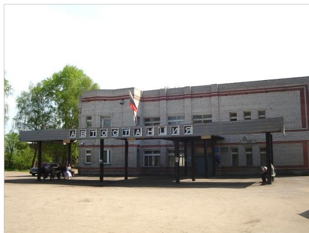
Рисунок 1.3 – Внешний вид автостанции в г. Красновишерске Красновишерского городского округа.
