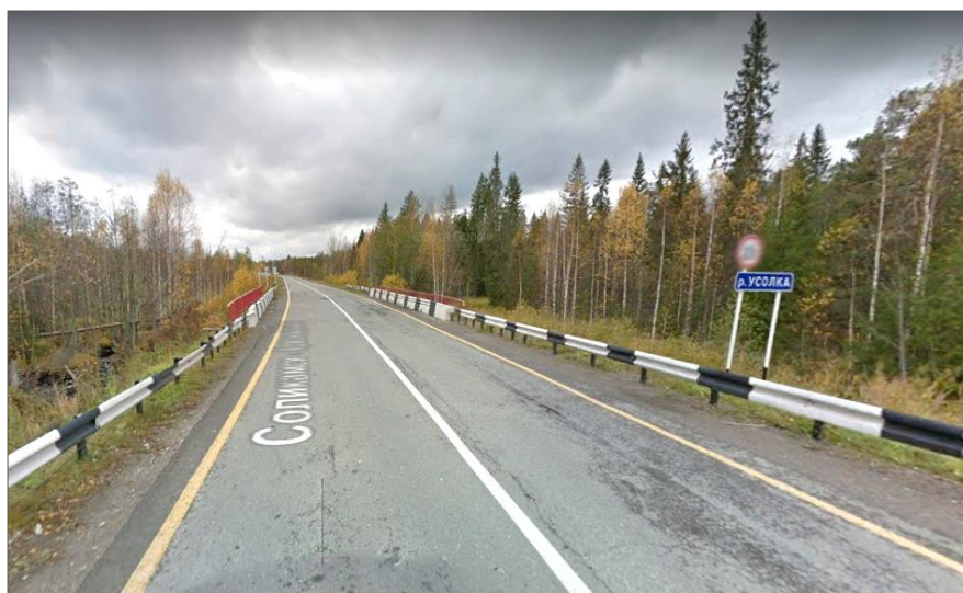
Рисунок 1.5.2 - «Фотоснимок моста через р. Усолка на дороге Соликамск-Красновишерск»
