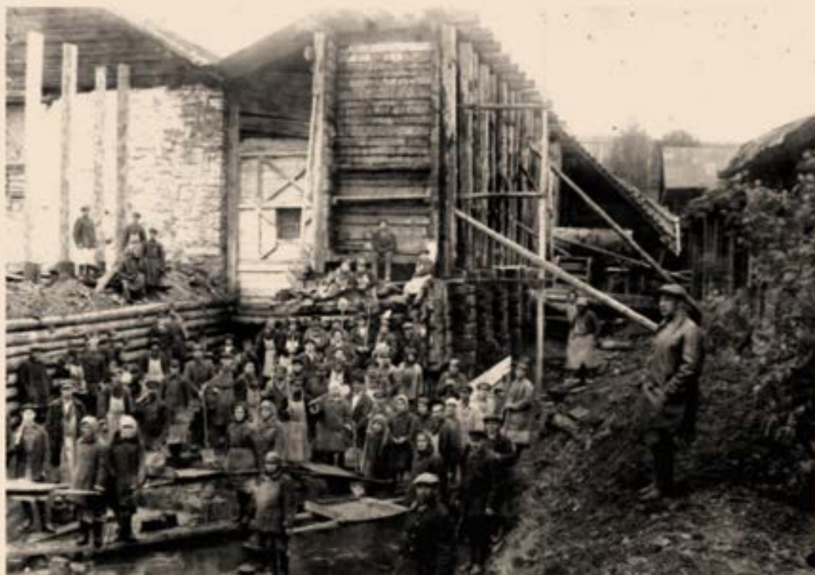
Строительство одного из цехов Суксунского завода
